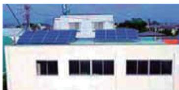
太陽電池145w×36枚設置 (5.22Kw)
