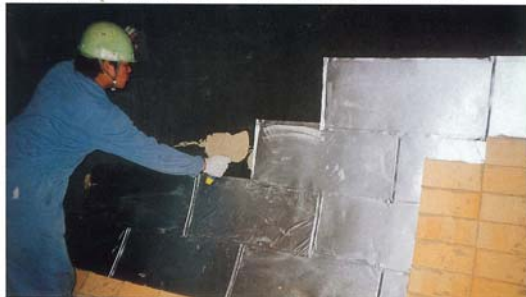
(3) 加熱炉内水冷配管 (Lambdaflex super)
