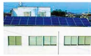
太陽電池128w×36枚増設（4.61kw）
