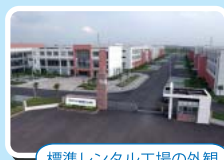
標準レンタル工場の外観
