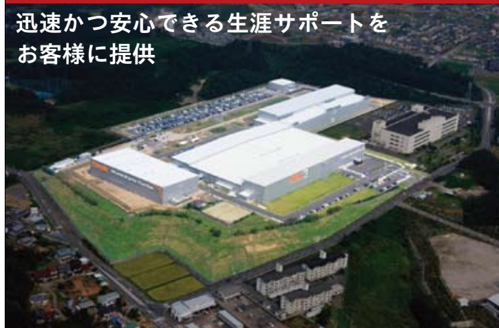
美濃加茂第二工場
