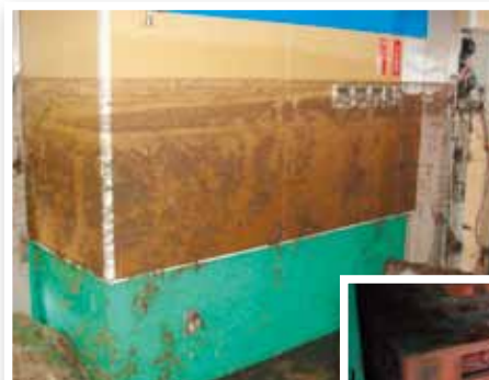
工場の壁には、津波の高さにくっきりと泥の線が残っていた。
