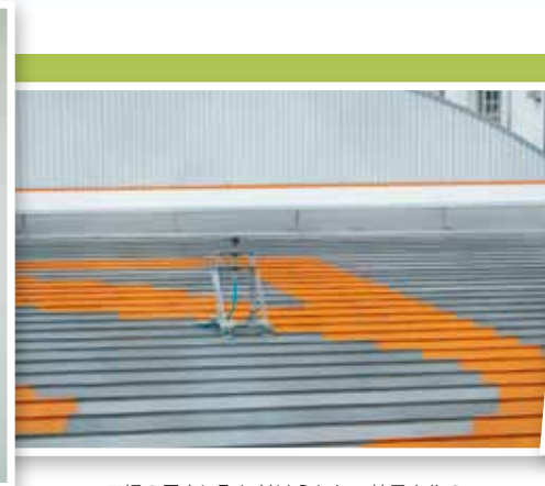
工場の屋上に取り付けられた、社員自作のスプリンクラー
