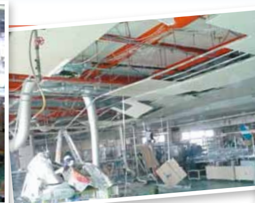
強い揺れにより、壁のタイルは剥がれ天井からぶら下がっている
