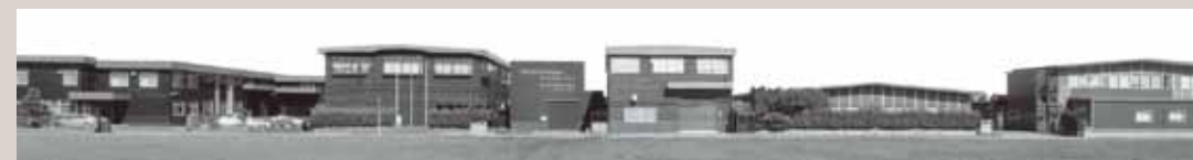
本社工場外観（岐阜県大垣市）
