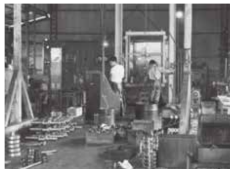
富士電子工業が創業して間もなく(1961年)。焼き入れ工場内部
