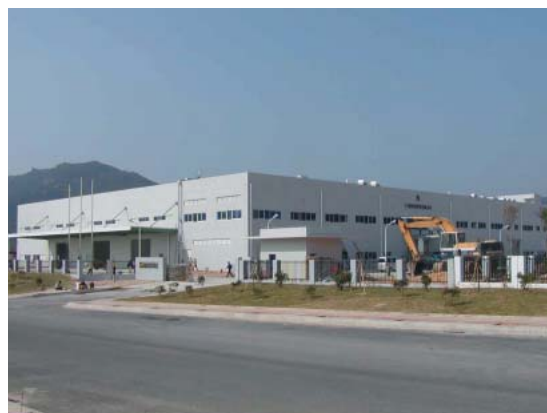
完成直前の広州泰賀塑料有限公司工場
