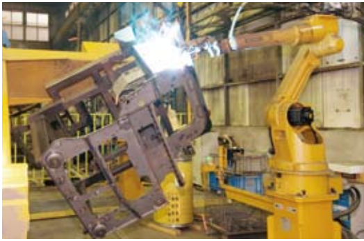
ロボットによる溶接
