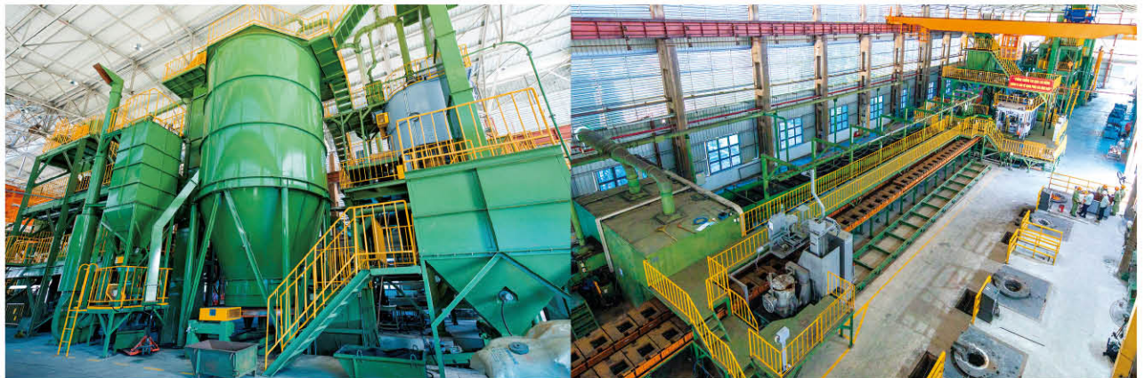
Dây chuyền đúc, rót khuôn cát tươi tự động - dây chuyền đúc hiện đại và lớn nhất Việt Nam hiện nay. Công suất: 10.000 tấn/năm
