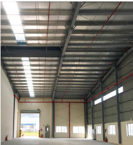
採光用の天窗と消火栓(赤いパイプ)
