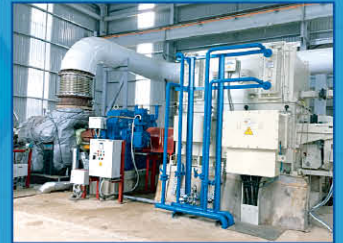
タービン発電機
