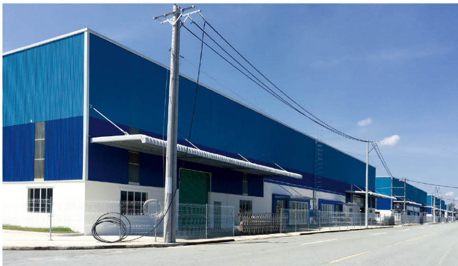
セキュリティ用のフェンスのある工業団地(BWID Bau Bang工業団地)
