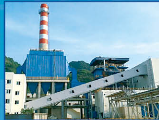
ボイラーシステム
