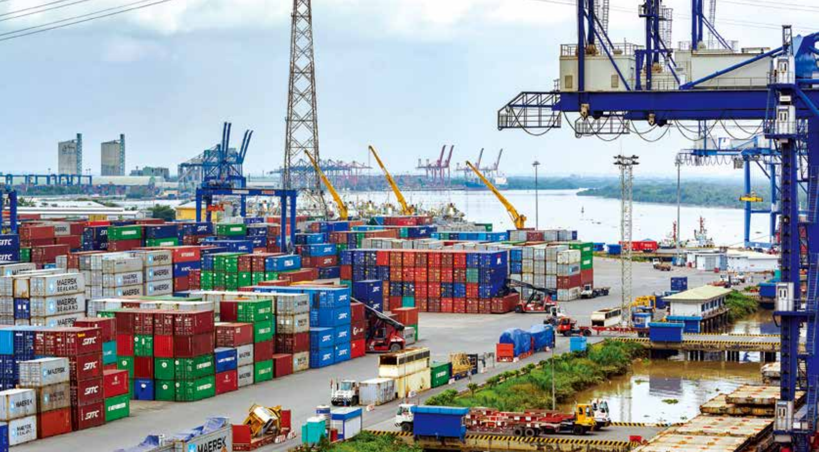
サイゴン・ニューポート・コーポレーション (SNP) が運営するコンテナターミナル
