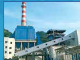
ボイラーシステム
