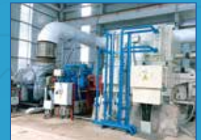
タービン発電機
