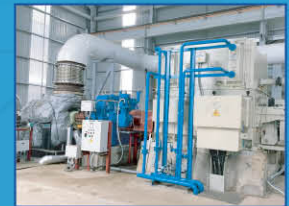
タービン発電機
