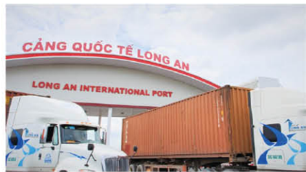
第2期工事を着工したロンアン国際港
