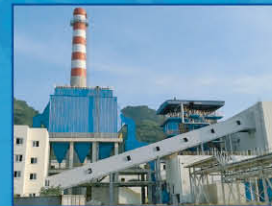
ボイラーシステム
