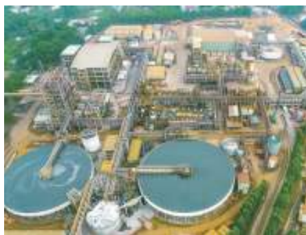
MHTの近代的なプラント
