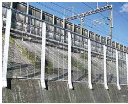
FRPを使用した新幹線線路防護柵
