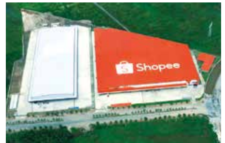
BWID社がBTSで建設したShopee (Eコマース) の倉庫
