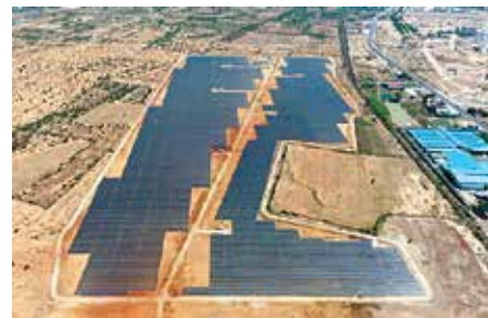
ニントゥアン省の太陽光発電所
