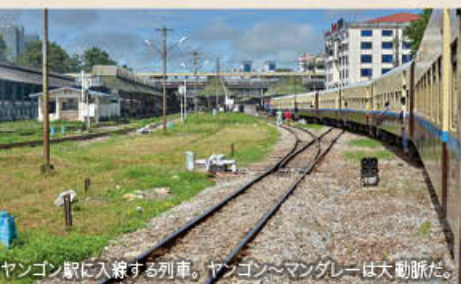
ヤンゴン駅に入線する列車。ヤンゴン～マンダレーは大動脈だ。
