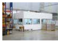
工場内オフィス設置
