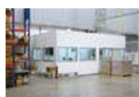
工場内オフィス設置
