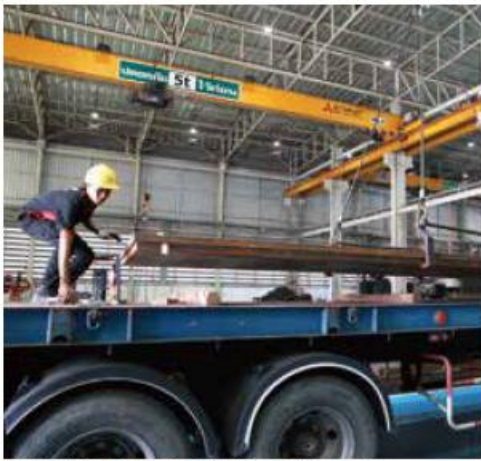
届いたばかりの鋼材。工場で各サイズに加工されていく
